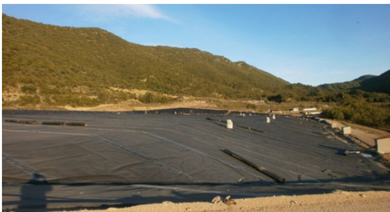
Estado final de los trabajos de impermeabilización temporal.
